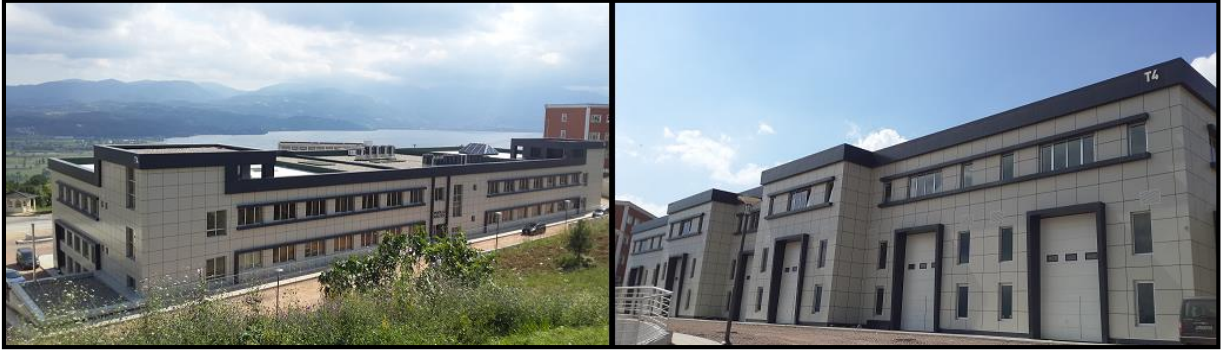
Teknoloji Fakültesi T4 binası
